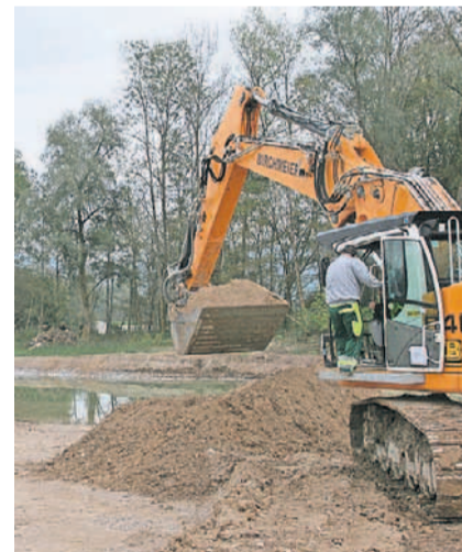
Am Rheinufer im Einsatz: Ein Bagger mit GPS.
